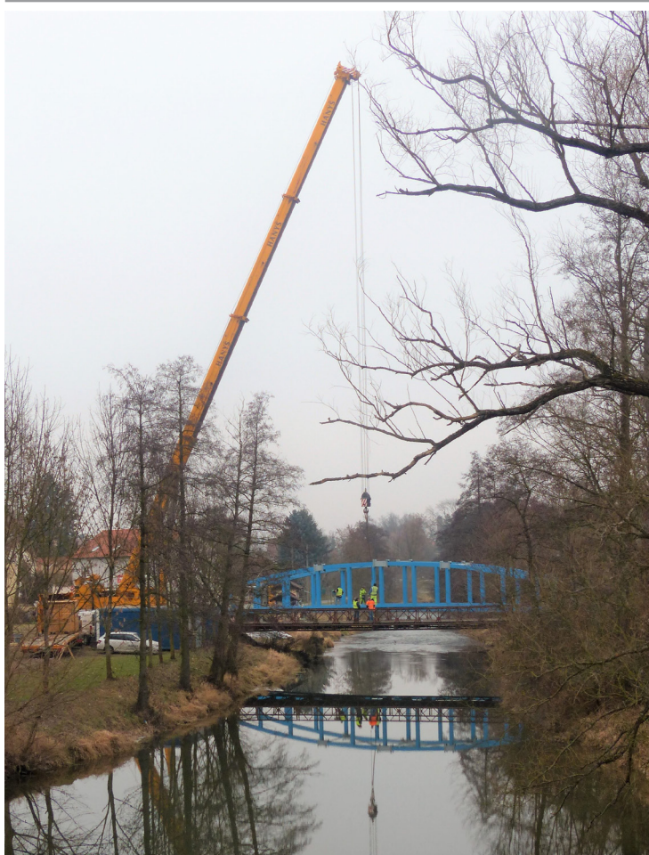
Těsně před Vánoci, 21. 12. 2016, byla za pomoci mohutného jeřábu usazena nová lávka přes Radbuzu...
