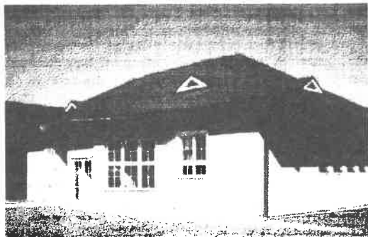
Otevření nové budovy pošty ve Staňkově.
